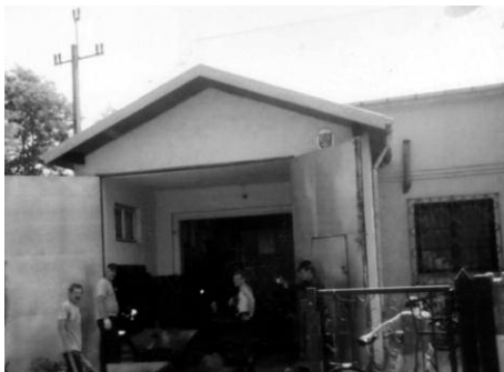
Rozbudowa strażnicy OSP w Zabieźkach – 2006 r. - Fot. pobrano z Kroniki Wsi Zabieźki
