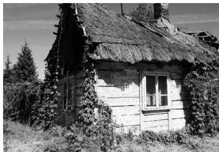
Niszczący dom w jednej z okolicznych wsi w pobliżu Osiecka - 2017 r. Na ścianach charakterystyczny niebieski kolor (tutaj niewidoczny) informujący o zamieszkującej go kiedyś pannie na wydaniu - Fot. autora
