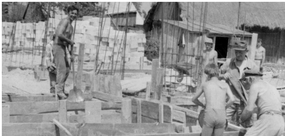
Zalewanie fundamentów. Z lewej widoczny m.in. Zygmunt Kwaśniak, przy szalunku Jan Zduńczyk - Fot. rodziny Wasążników
