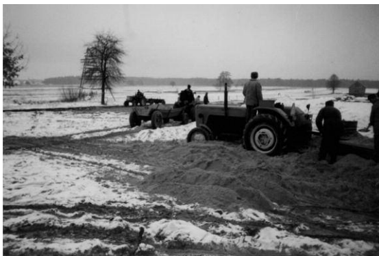
Z lewej strony zdjęcia schowany za drzewem trójnog zbudowany w miejscu odwiertu na potrzeby planowanego wodociągu. Zdjęcie wykonane przy okazji prac przy budowie plebanii. Fot. udostępnił ks. Marek Kukiel
