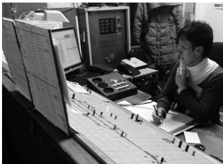
Stanowisko dyżurnego ruchu. Widoczny na zdjęciu pulpit sterowniczy z odwzorowaniem układu torów kolejowych na terenie stacji – listopad 2014 r. - Fot. autora
