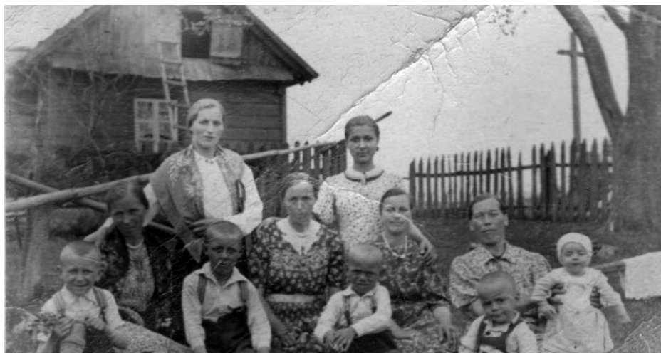
Pamiątkowe zdjęcie na tle rozebranego w 2015 r. domu na posesji nr 54/56 przy ul. Żurawinowej.
