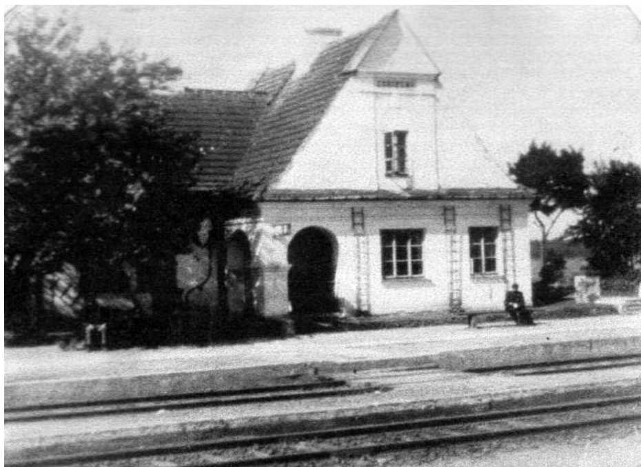
Budynek stacji kolejowej w Zabieźkach – lipiec 1939 r. – pobrano z: Kronika wsi Zabieźki - t. I
