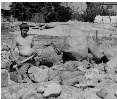
Tłuczenie kamieni na podmurówkę. Obok: spawanie stalowej konstrukcji więźby dachowej. Prac dogląda ks. Piotr Kryński - Fot. rodziny Wasząników
