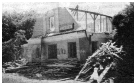
Rozbiórka budynku stacji kolejowej – czerwiec 2002 r. - Fot. z „Linii Otwockiej”
