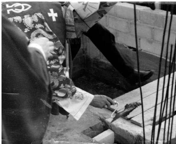
Wmurowanie kamienia węgielnego przez ks. biskupa Jana Mazura - 29 czerwca 1982 r. - Fot. rodziny Wasząników
