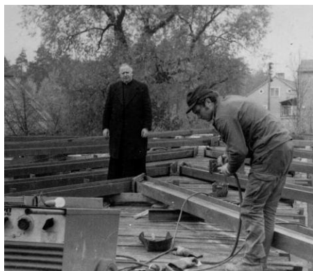
Tłuczenie kamieni na podmurówkę. Obok: spawanie stalowej konstrukcji więźby dachowej. Prac dogląda ks. Piotr Kryński - Fot. rodziny Wasząników
