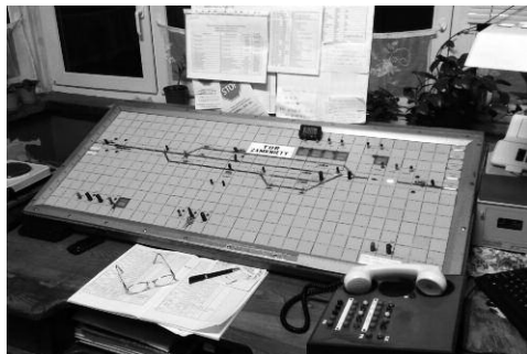
Stanowisko dyżurnego ruchu. Widoczny na zdjęciu pulpit sterowniczy z odwzorowaniem układu torów kolejowych na terenie stacji – listopad 2014 r. - Fot. autora
