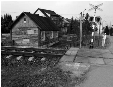
Widok domu przy przejeździe, po opuszczeniu go przez mieszkańców – 2019 r. - Fot. autora
