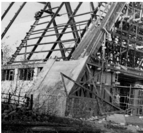
Montaż konstrukcji więźby dachowej - Fot. rodziny Wasząników
